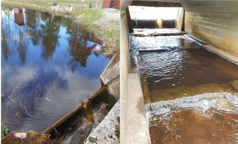
Figur 32. Branddammen uppströms dammvallen (vänster bild) samt vy under vägbro mot utskovet (höger bild). I såväl lucka som utskovsbotten/skibord finns slitsar för att koncentrera vattnet vid låga vattenflödet.
